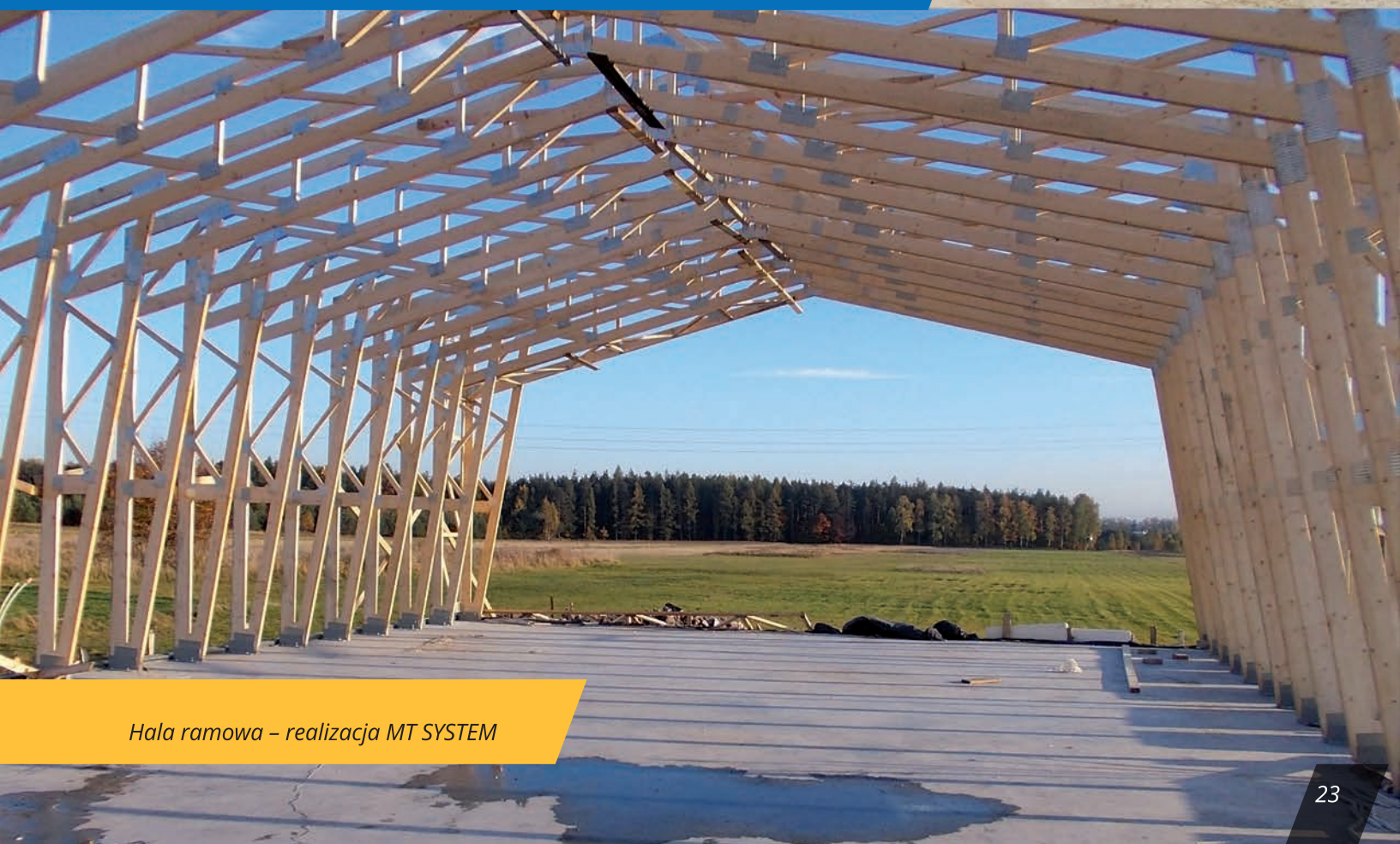
Hala ramowa na zakład produkcyjny (realizacja WIĄZARY BURKIETOWICZ)
