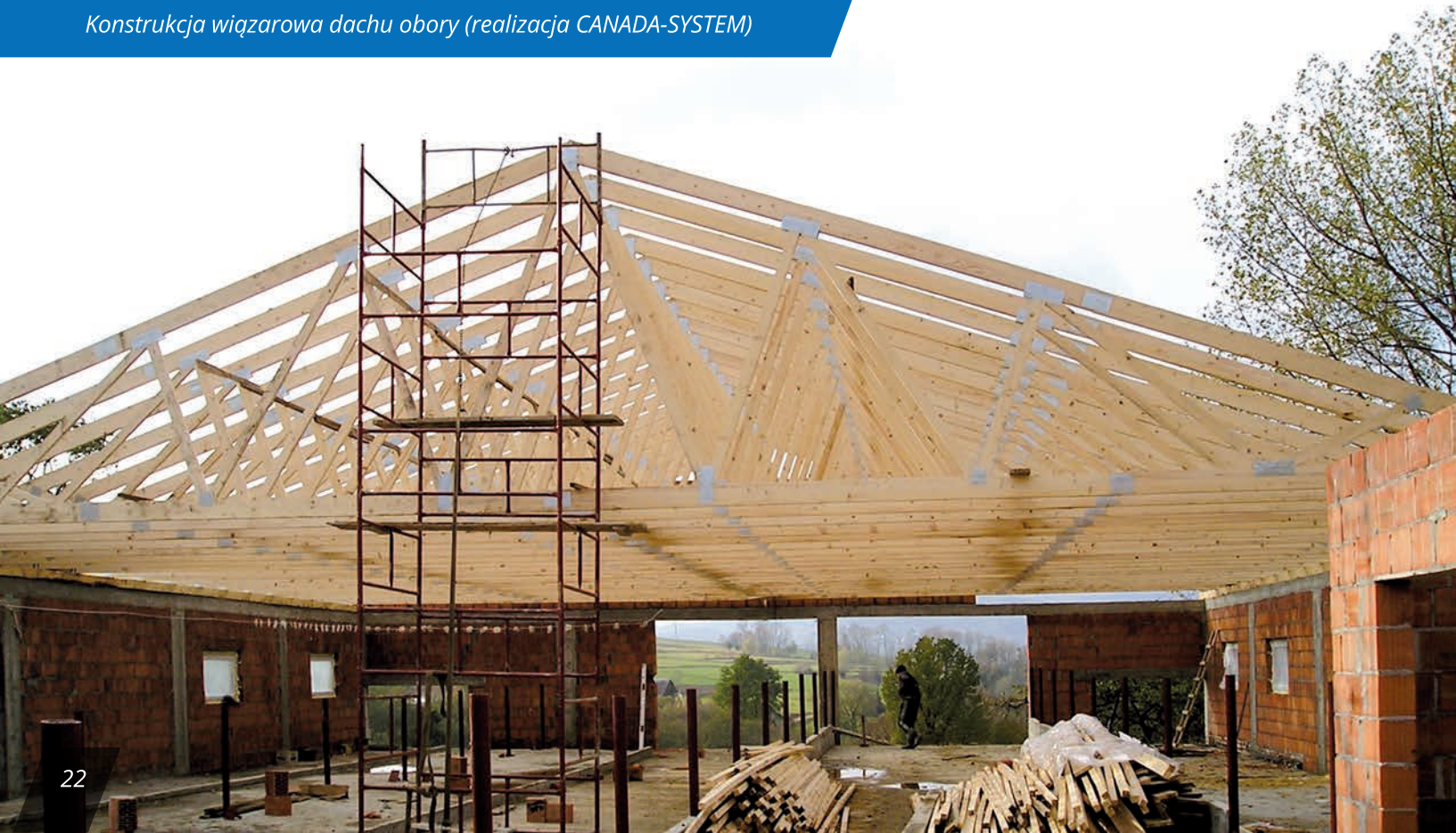
Montaż dachu na kurniku (realizacja WITKOWSCY)
