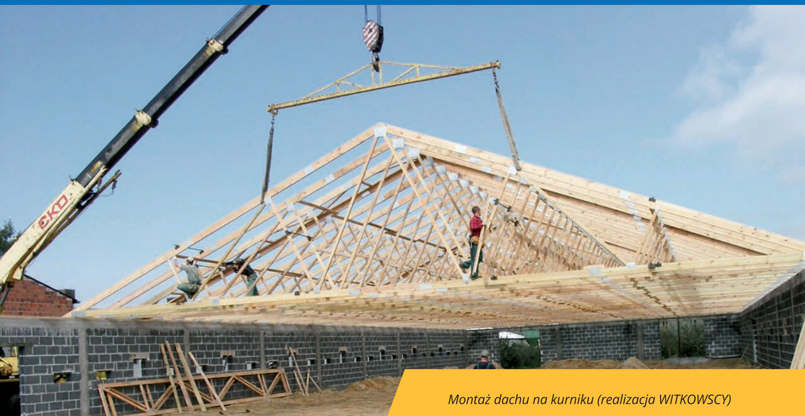
Konstrukcja więzaru dachu obory (realizacja CANADA-SYSTEM)
