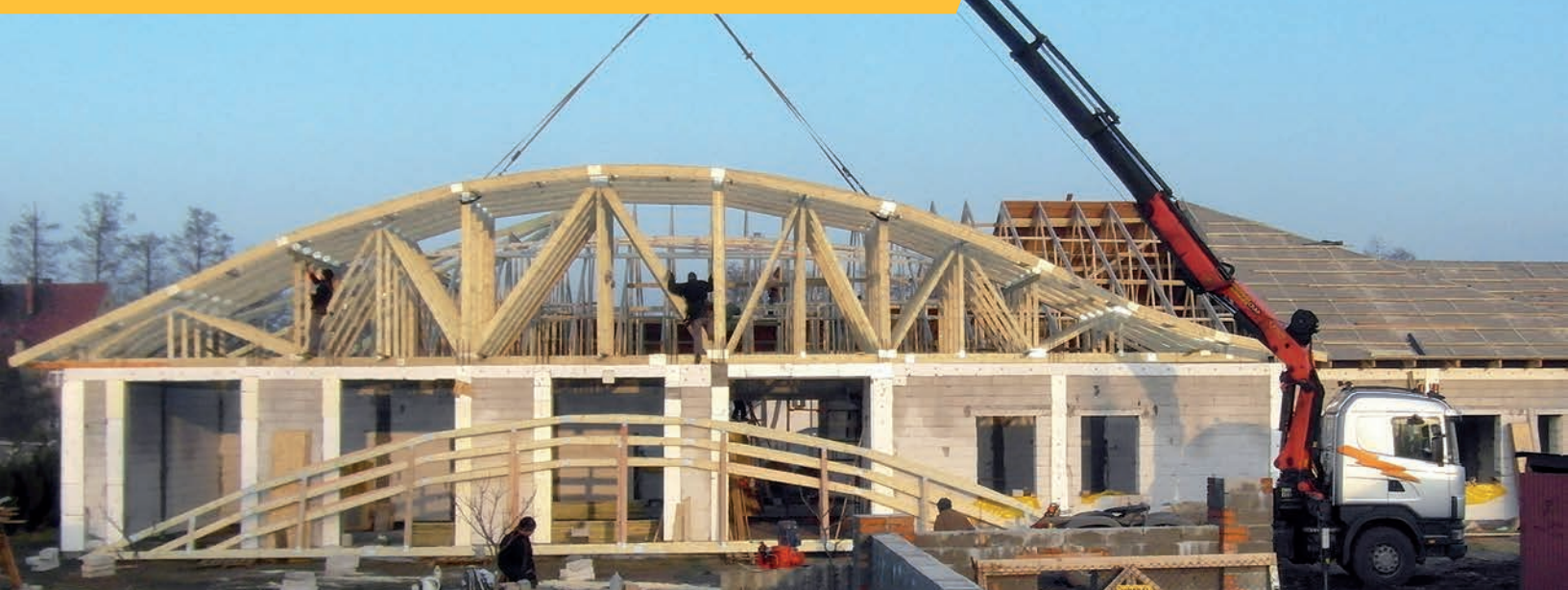
Montaż więźarów o dużych rozpiętościach (realizacja DREWPROJEKT)
