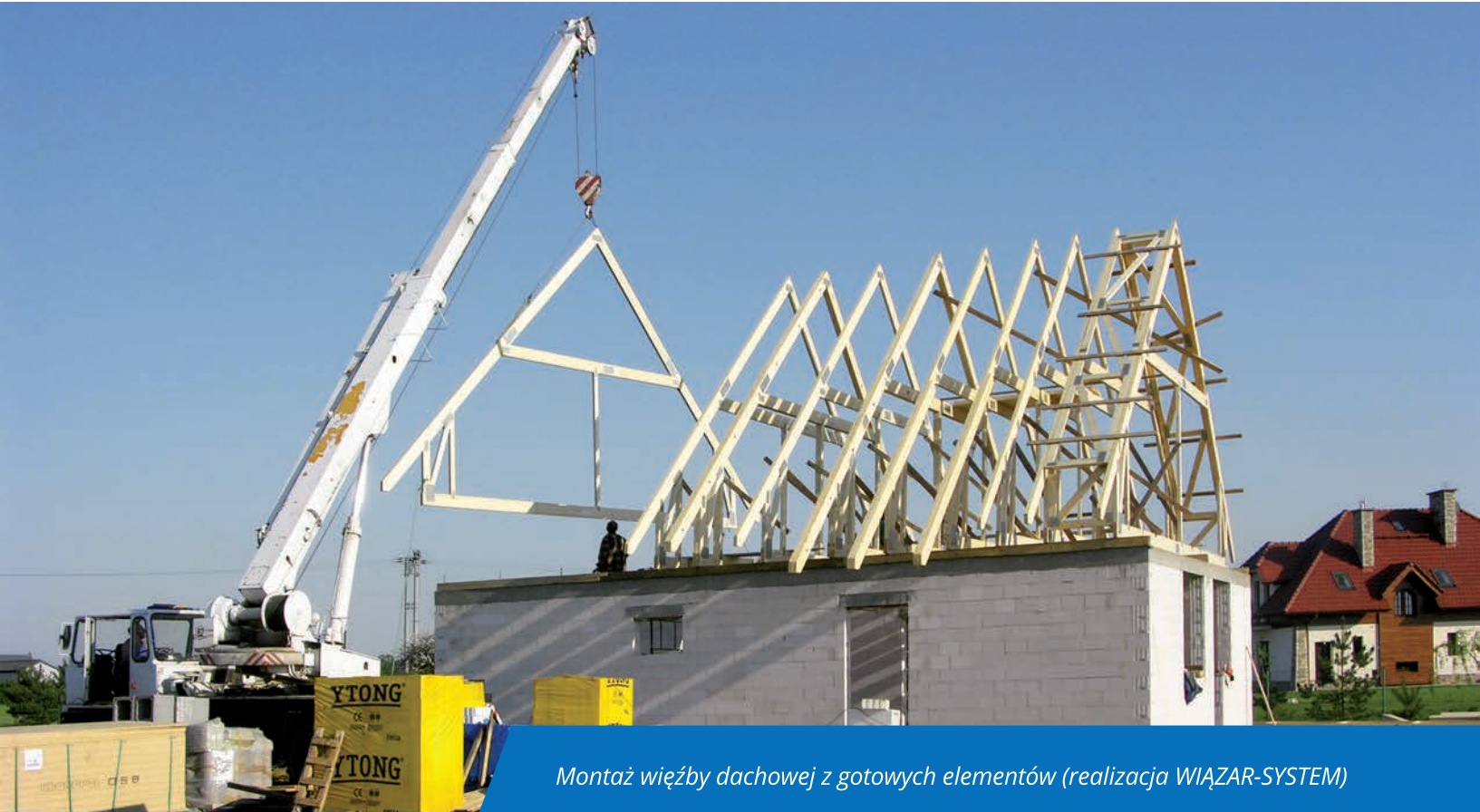
Montaż więźarów o dużych rozpiętościach (realizacja DREWPROJEKT)
