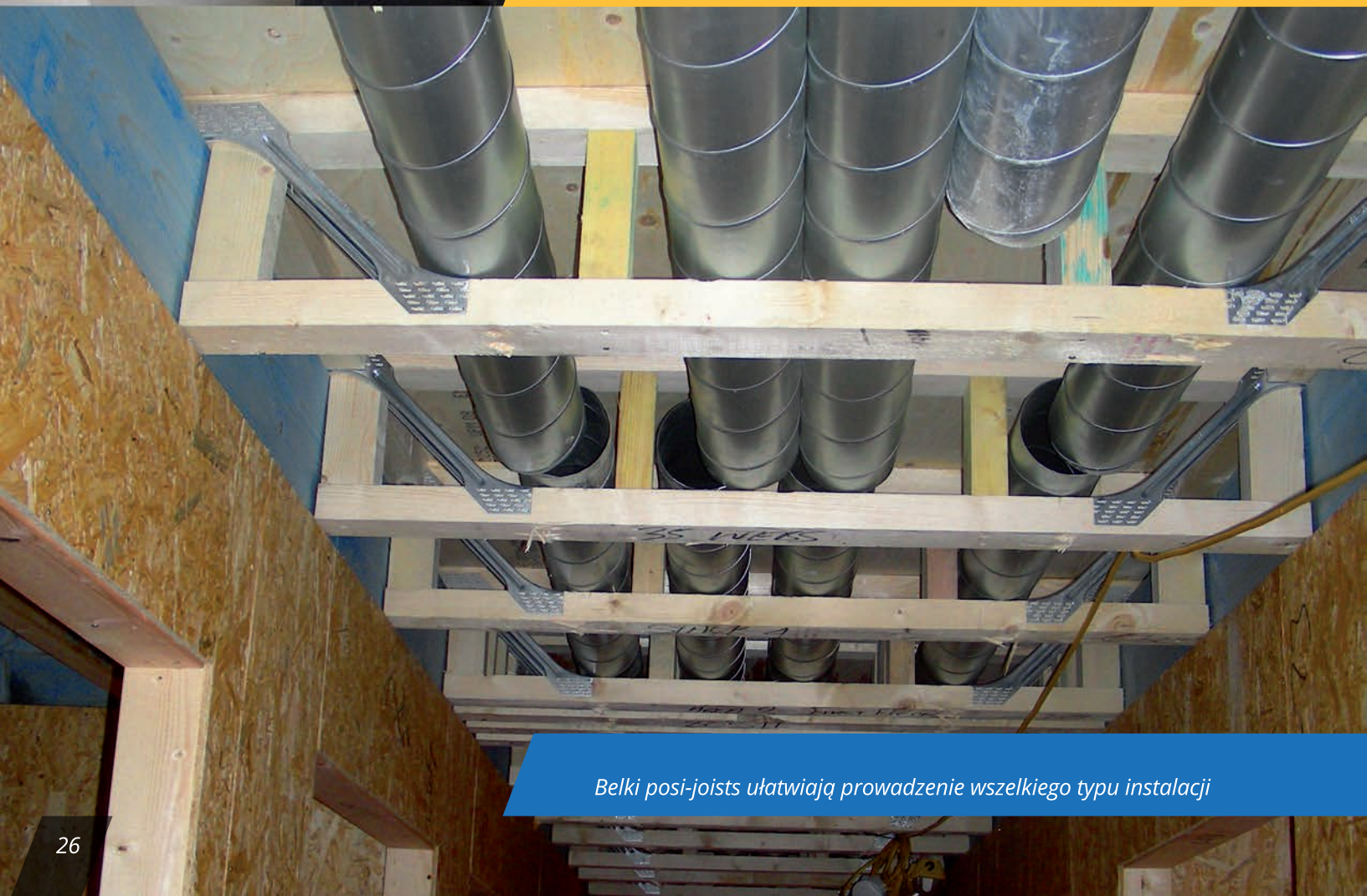
Montaż belek „posi-joists” (realizacja WIĄZARY STANISZÓW)
