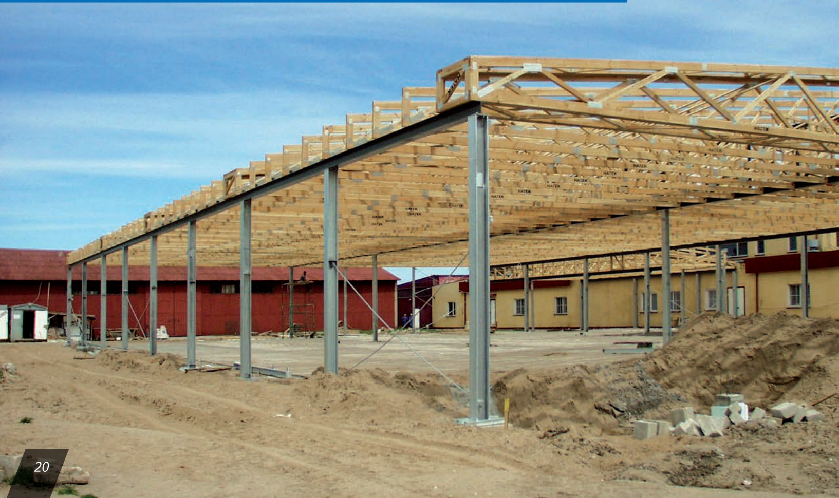
Konstrukcja dachowa na szkielecie stalowym – budynek magazynowy (realizacja HATEK)
