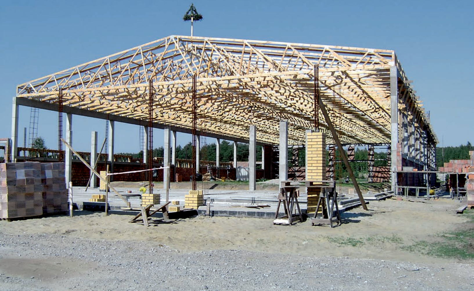
Konstrukcja z drewnianych więzarów na konstrukcji żelbetowej (realizacja ERAGA)
